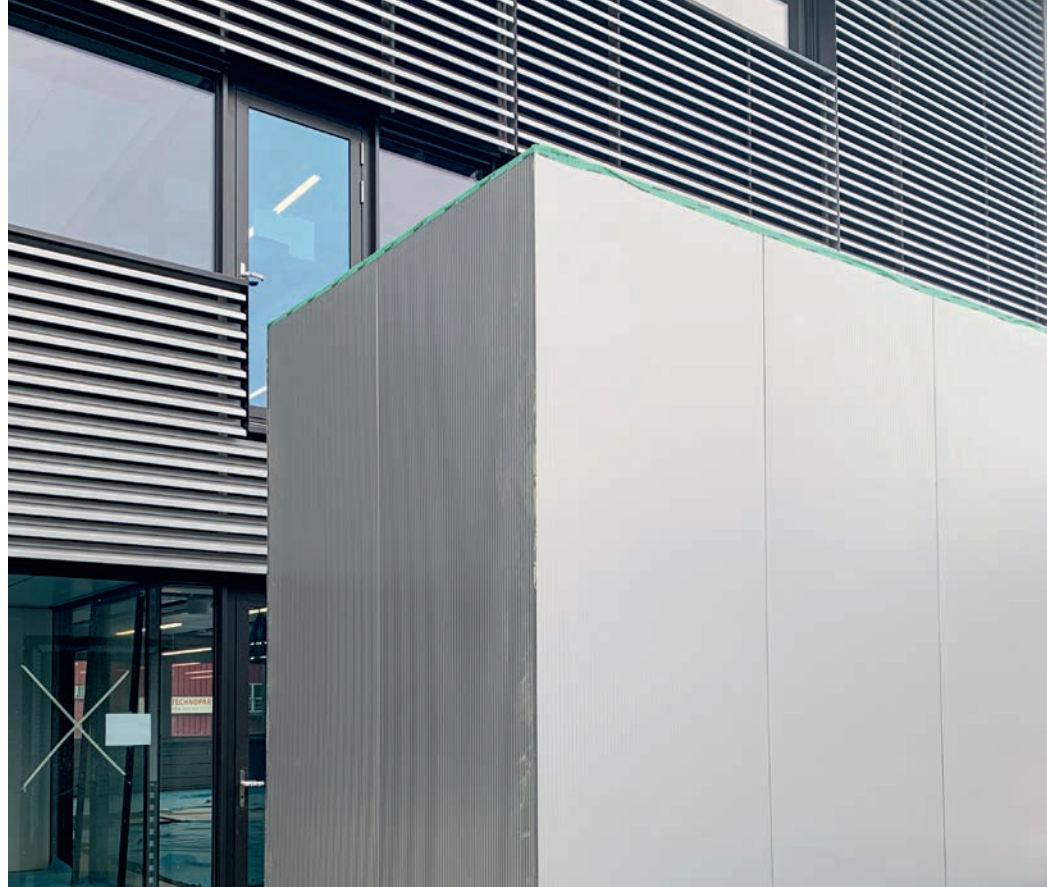
Treppenhäuser und Aufzugsschächte werden mit Sandwich-Elementen bekleidet (oben). Die bestehenden Hallen erhalten dank neuer Fensterbänder mehr Licht (unten).
