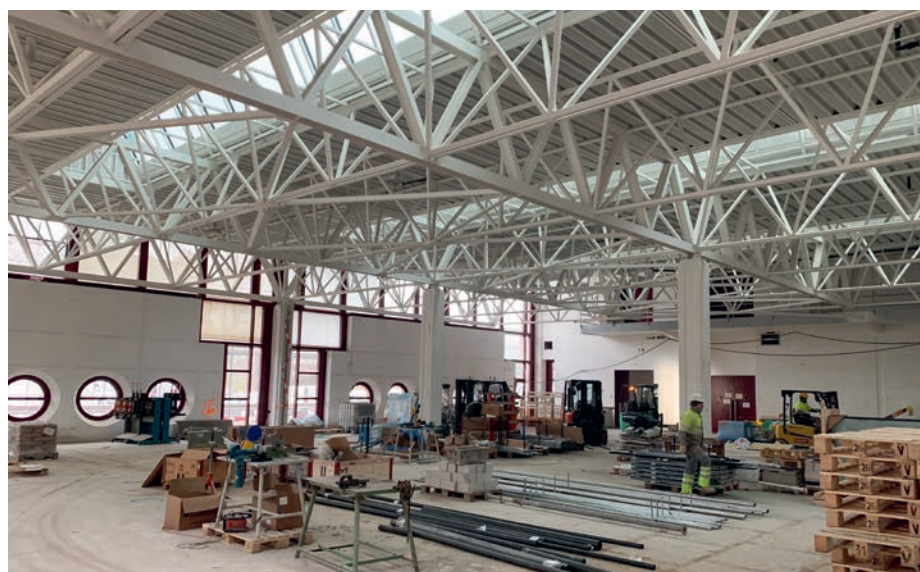
Treppenhäuser und Aufzugsschächte werden mit Sandwich-Elementen bekleidet (oben). Die bestehenden Hallen erhalten dank neuer Fensterbänder mehr Licht (unten).
