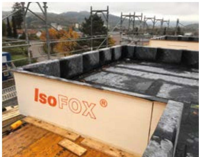
Je nach Witterung sollten nach ca. 5 Tagen nach dem Betonieren der Betondecke die **IsoFOX Dachkranzelemente** flächenseitig wasserdicht mit Dichtungsbahnen (z.B. mit einer Dachpappe) beschichtet werden, damit kein Wasser beim Anschluss des Elementes an die Betondecke und bei den Elementstößen in die Elemente fließen kann. So werden gleichzeitig die Fassadenmauern, dank dem Überstand der Elemente über Fassadenflucht, vor Durchnässen mit Wasser, das von der Betondecke fließen würde, geschützt.
