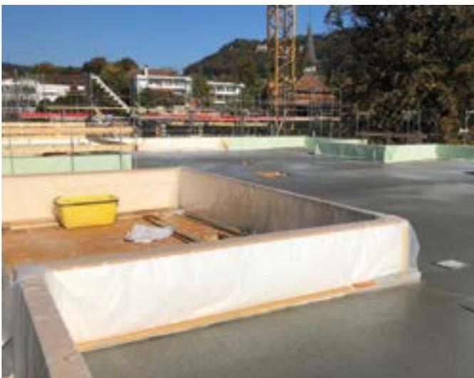
**IsoFOX Dachkranzelemente** haben auf der Brüstunginnenseite eine wasserabweisende Beschichtung, welche die Elemente während der Bauzeit optimal schützt. Trotzdem müssen die Elemente **während des kompletten Arbeitsablaufs** vor Nässe und Schmutz geschützt werden.
